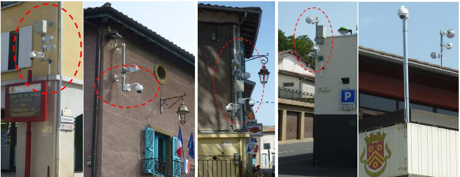
Réseau des télécommunications de la ville de Genay . Maillage IP Ethernet Full Duplex 100 Mbps construit avec des Faisceaux Hertiens Hypercable de type HyperBridge 24 Ghz, antennes Urbaines de 20 cm et de 35 cm.
